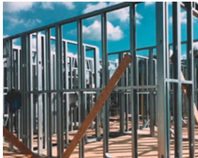
Bei RiModul® frame werden die Profile im Produktionswerk zu 2D Rahmenelementen vormontiert und montagefertig auf die Baustelle geliefert. Die weitere Plattenbeplankung und Aussendämmung erfolgt anschliessend bauseits.
